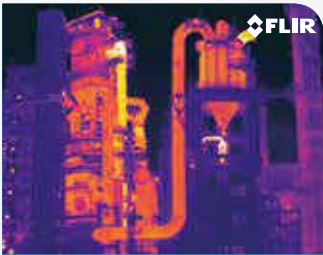
Monitoramento permanente de instalação petroquímica para maior segurança.
